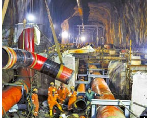
1 저장동굴 내부 전경. 2 아시아 오일 허브로서 바빠질 입출하 부두. 3 저장동굴 내부 운영을 위한 단계 구간. 4 배관 시공 당시 사진.
