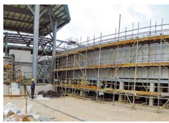
지하 터널부와 지상 부를 연결해 주는 수직구(Access Shaft) 공사 모습.
