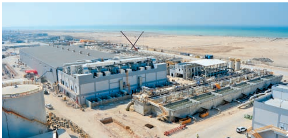
1 UAE 미르파 담수 복합화력발전소 전경. 푸른색 쪽빛의 바다가 작업장을 품고 있다. 2017년 4월 발전소가 완공되면 1600MW급 전력과 하루 23만 8000t의 음용수를 생산하게 된다. 2 수처리를 담당하게 될 RO 플랜트. 3 화력발전용 스팀터빈(STG) 작업 현장.
