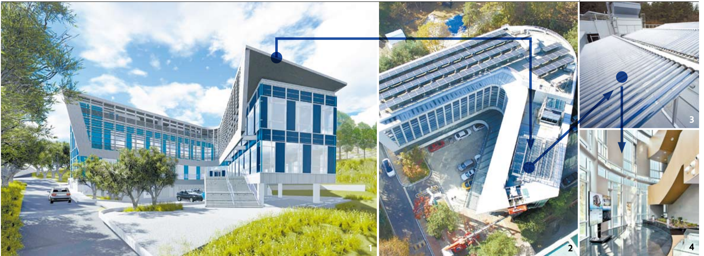
우리 회사가 지난 2014년 11월에 건립한 그린스마트 이노베이션 센터(GSIC, 사진1)의 옥상에는 태양열 집열판이 설치(사진2,3)돼 태양열을 활용한 냉난방(사진4)이 이뤄지고 있다. 이를 통해 연 210만원의 가스비 절감을 이뤄냈다.
