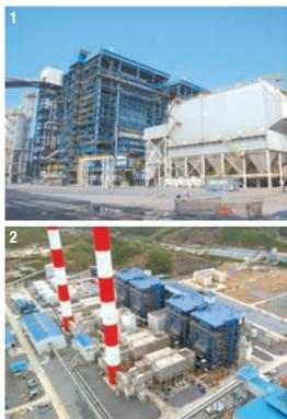
1 1호기 보일러, 전기집진기(ESP) 전경. 2 보일러 4대, 스택터빈 2대, 전기집진기 4대, 연돌 2대를 포함한 1, 2호기 Power Block.
