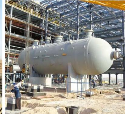
1 사우디 우쓰마니아 에탄회수처리시설 공사 현장 전경 2 현장의 주요 기기 중 하나인 팽창기 가스 분리기(Expander Feed Separator)가 설치된 모습. 3 기존 공장 내에 설치된 파이프랙(Pipe Rack) 시설물. 4 두 대의 크레인을 이용한 탠덤 리프팅 방식으로 에탄회수처리시설의 핵심 장비인 디메타나이저를 설치하고 있다. 5 공역식 열교환기(Air Fin Cooler) 시공 모습.
