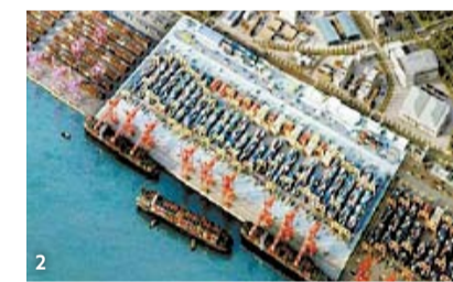
1 인천 집단 물류센터 신축공사, 2 인천 신항 1-2단계 컨테이너 부두 허부공 축조공사.
