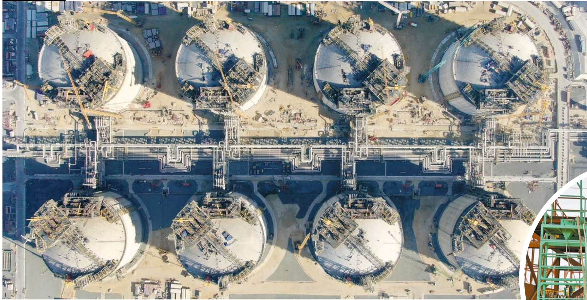
1세계 최초 LNG 저장탱크 8기를 동시에 건설하는 현장. 바다 위 그 위층이 대단하다. 2 국산, 일본 산 용접재료 비교 시험을 위한 논의가 한창이다. 3 극저온용강(극저온의 구조용 철강 재료) 실제 용접 후 육안 검사. 4 현지 해수, 현장의 철관을 사용해 실제와 같은 조건에서 부식방지제 선정을 위한 시험을 진행했다. 5 용접 방법과 부식방지제 브랜드에 따라 다양하게 시험된 시편.
